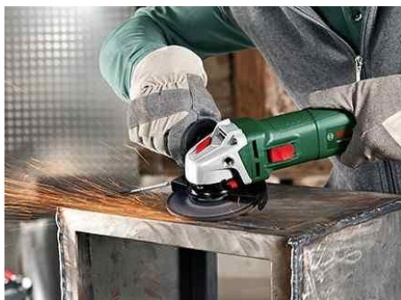
Rys. 6.8. Oczyszczanie metalu szlifierką kątową
