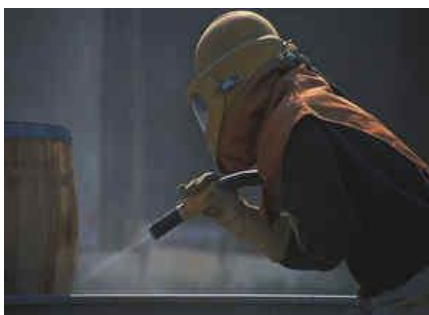
Rys.6.9. Piaskowanie powierzchni metalu
